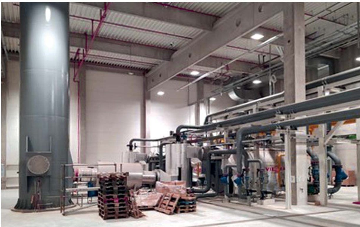
GreMi KLIMA buduje kotelnu a kompletní rozvody topení a vzduchotechniky. Dohromady jde o 39 km potrubí.
