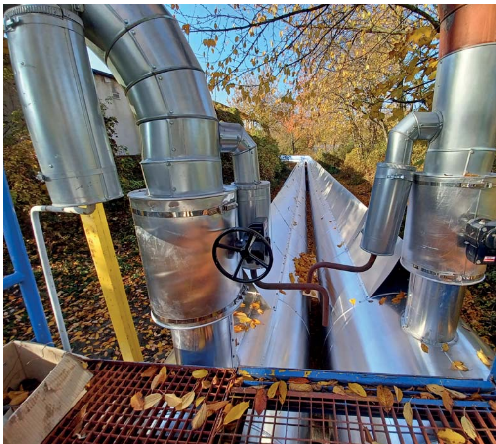
Výměna části potrubí TN TMA Západ v Praze Sazečské ulici.
