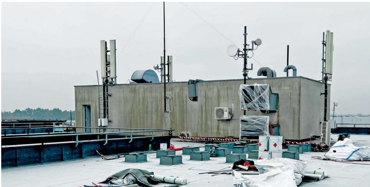
Jednotky VZT po demontáži a finálním dokončení.
