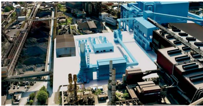
Oceliareň Voestalpine, Rakúsko.
