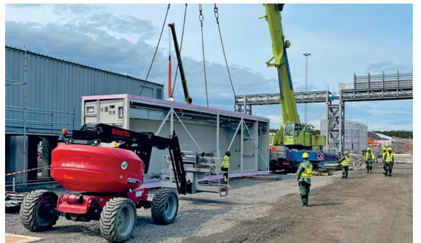
Montážní práce v severošvédském Bodenu už běží naplno.
