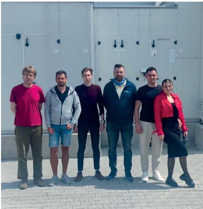
Vzduchotechnická jednotka firmy Stannah Stairlift s týmem pracovníků pobočky GreMi KLIMA Brno VZT.
