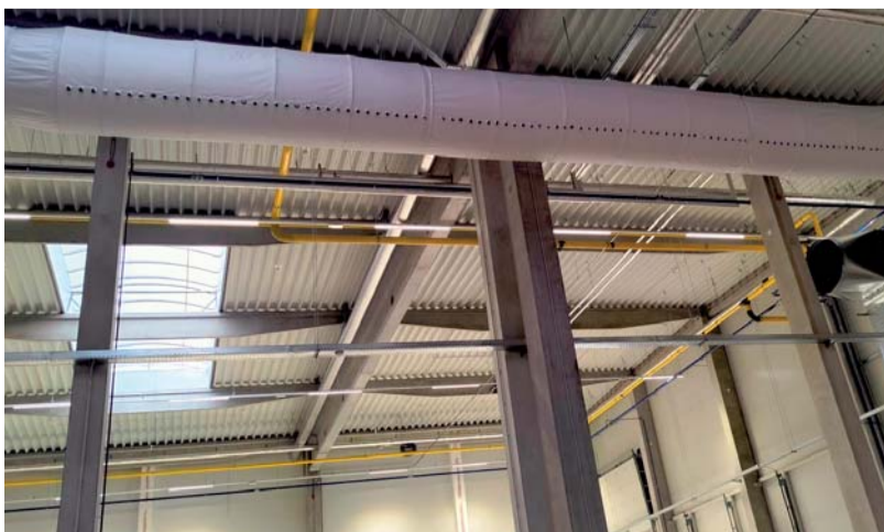
Osazení prvního ze dvou textilních výústků v lakovně firmy Stannah Stairlift.
