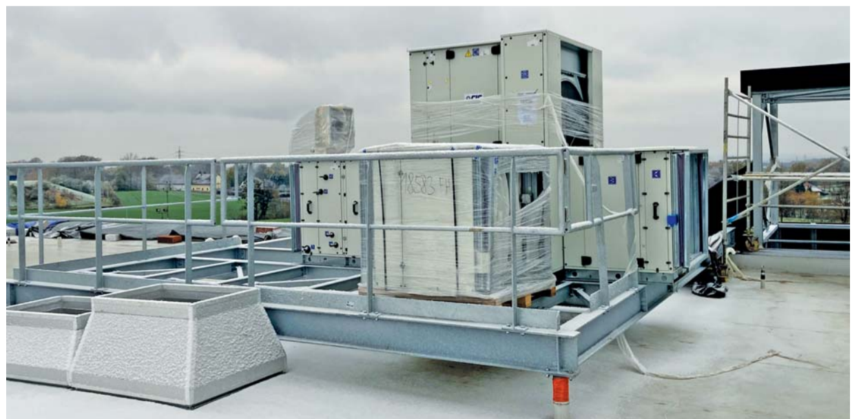
Vzduchotechnická jednotka na střeše základní školy po usazení jeřábem.
