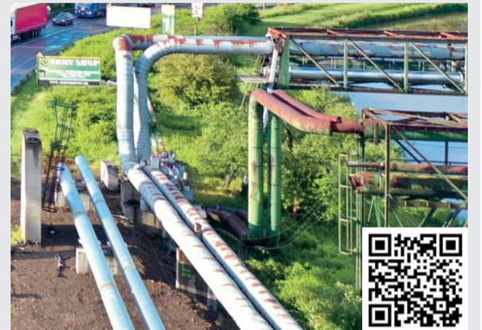
Martin, video z demontáže 37 tonového mosta cez QR kód.
